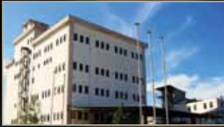
• Cracking Unit / Findık Kırma Tesisi
